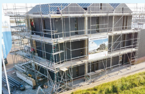
De bouw van het hotel vordert gestaag.
