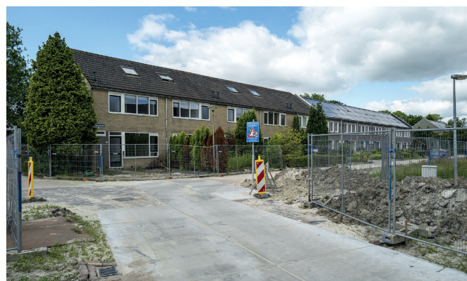
Op de plek van dit woonblok wordt dit najaar één van de twee vijvers in de wijk aangelegd.
